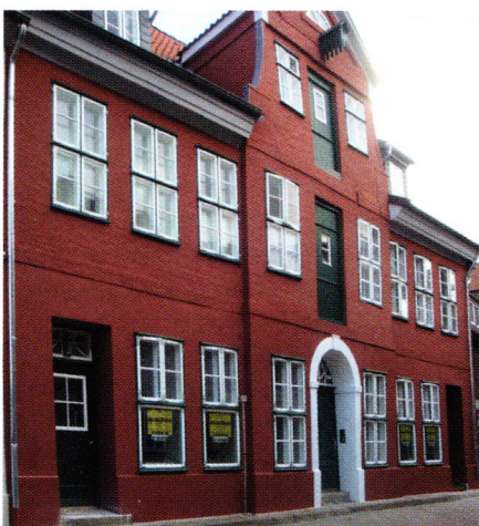
1 Lüneburg, Salzstraße 23, Vorzustand.
