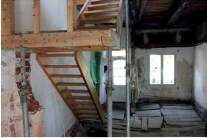
Abb. 1b: Nach Entfernung Zwischendecke
