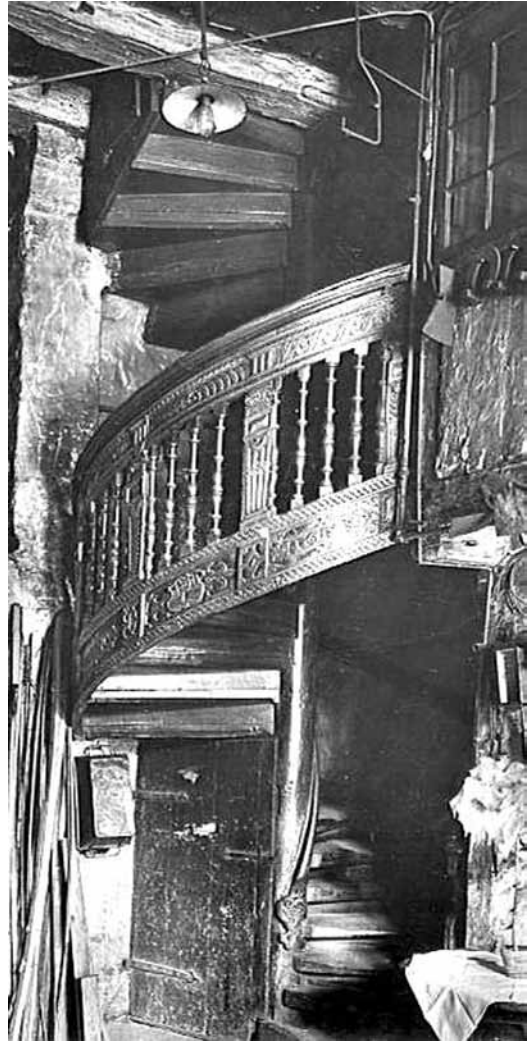
Abb. 50: Wendeltreppe im Haus Bardowicker Straße 25. Ausschnitt aus Foto Messbildanstalt 1915, Museum Lüneburg H111
