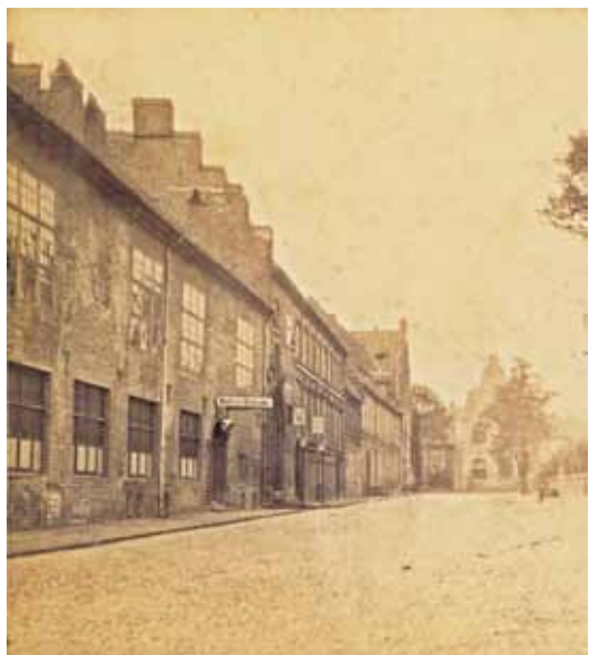
c. Zwischen 1869 und 1881, Nordfassade Ratshaus ohne Portal von 1590. Kalender Einhornapotheke 09-2010, Ausschnitt
