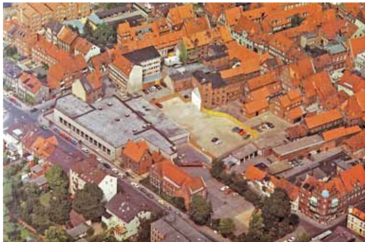
Brauerei-Komplex Wall-, Ritter-, Heiligengeiststr. 39-41. Abfüllanlage an Wallstraße und auf Ritterstraße. S. Dammann, Lüneburg von oben, 1990
