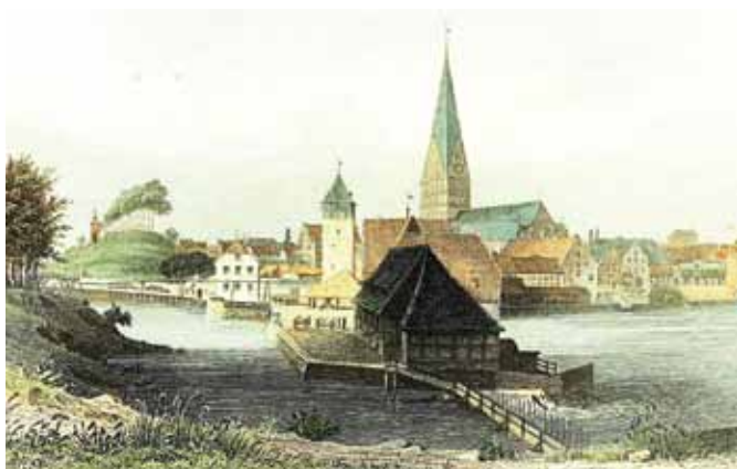
1843, Ratsmühle und Roter Wall mit Salinengestänge. Lill, Stahlstich
