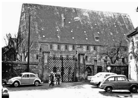
Glockenhaus-Sanierung. Bauhof mit Mauer und Tor. Foto: K.E.Giesecking
