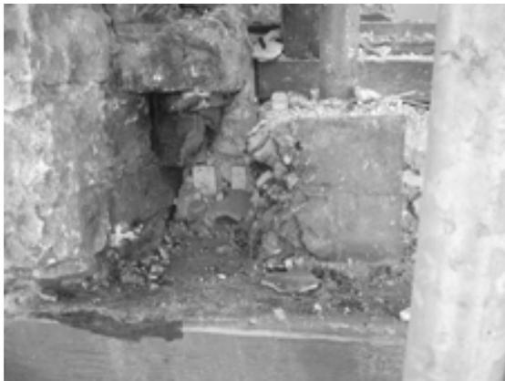
Abb. 3: Abgesägter Kragbalkenkopf des Erkers zur Engen Straße
