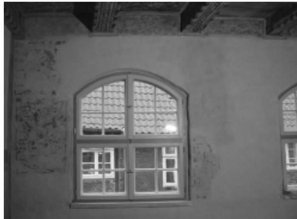
*Abb. 4: Südwand, rechts vom Fenster der versottete Bereich wurde mit Schellack isoliert und mit der oben genannten Lasur überstrichen*
