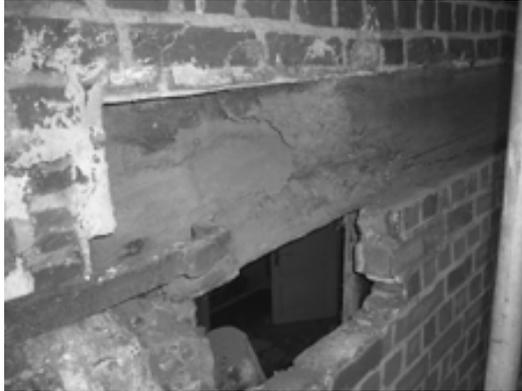
Abb. 2: Die Trennwand zur Straße bestand nur aus einer halbsteinigen Backsteinwand
