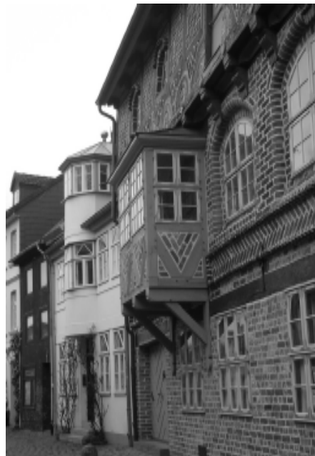
Abb. 5: Obere Ohlingerstr. Blick nach Süden, neuer Erker, rekonstruiert
