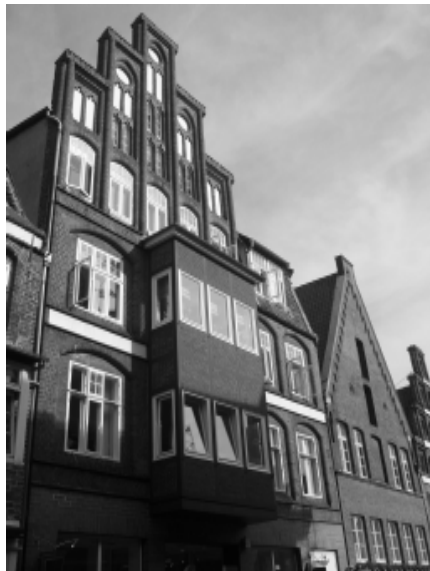
Abb. 9: Denkbare schlecht restaurierter Erker Am Sande. Wie ein unförmiger Kleiderschrank hängt der Erker am Haus. Ihm wurde sämtliche Gliederung und Sprosse genommen.
