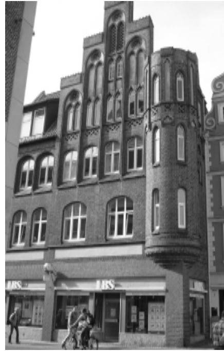
Abb. 8: Am Sande 4. Der gewaltige dreigeschossige Erker gleicht eher einem Treppenturm
