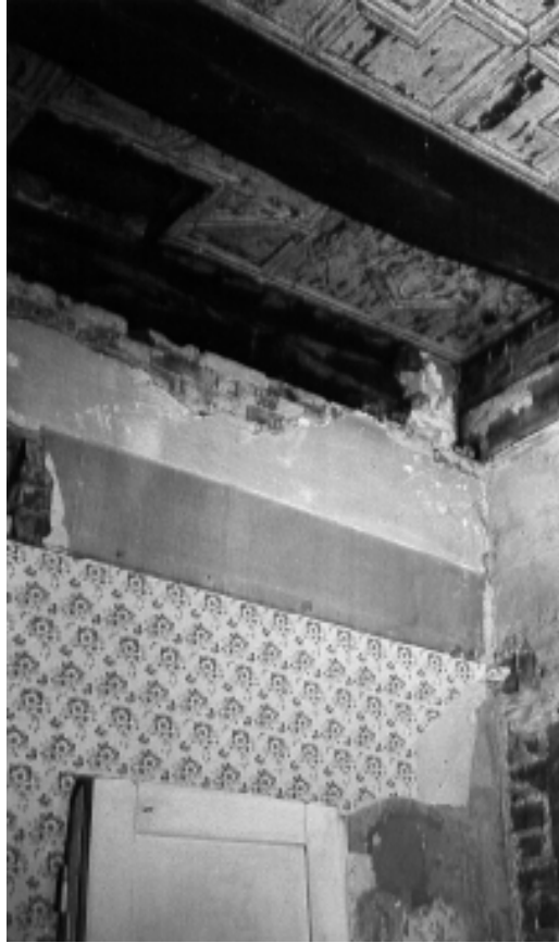
Abb. 2: Lünnerstr. 12. Warmlüftöffnung über dem ursprünglichen Standort des Hinterladens (Bilegger) in der sehr aufwendig gearbeiteten Kassettendecke der Dönz.
