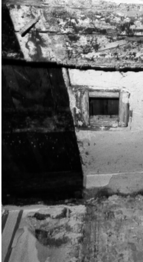
Abb. 3: Warmluftöffnung im Hause In der Techt 6, einem kleinen eingeschossigem Haus. Deutlich ist die schwarze Decke der ehemaligen Küche gegen den Wohnraum Dönz abgegrenzt. Die doppelte Begleitlinie vor der ehemaligen Wand zur Küche ist ebenfalls gut erkennbar. Die Warmluftöffnung ist auch von einem Begleiter eingefasst.
