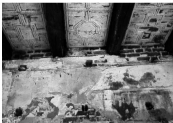
Abb. 1: Die Decke war in verschieden geschmückten Mustern gestaltet, ursprünglich waren die Deckenbalken ebenso in die Vertäfelungen einbezogen, dies wurde offenbar zu einem späteren Zeitpunkt beseitigt.
