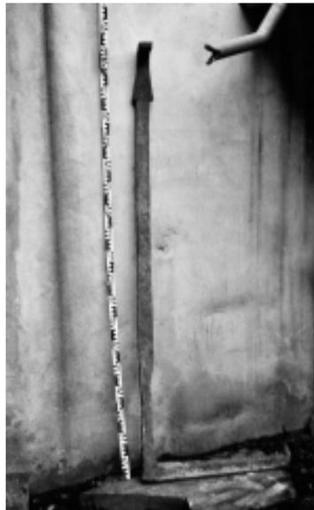
*Abb. 2: 160 cm stark wart die Klostersteinmauer die dieser Maureanker mit dem Deckenbalken verband.*
