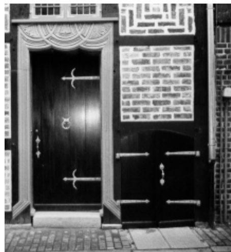
und nach der Restaurierung
