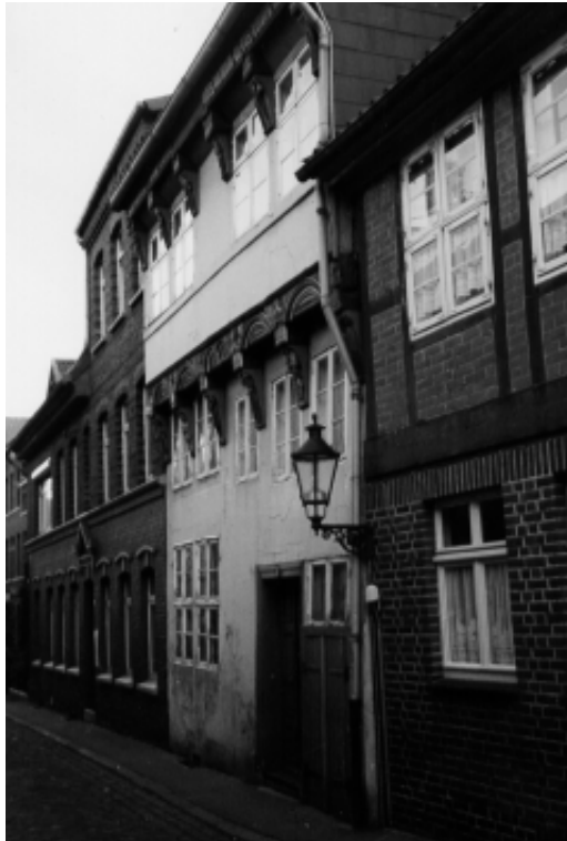
Baumstraße 3 vor der Sanierung
