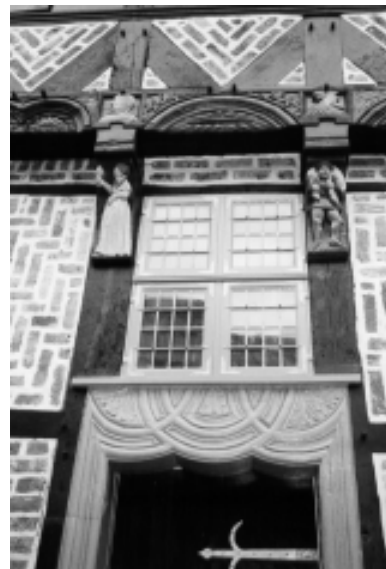
Vorhangbogen und Oberlicht nach der Restaurierung
