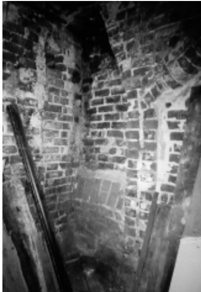
Rest eines alten offenen Kamins in der Achterstube (aus dem Vorgängerbau)
