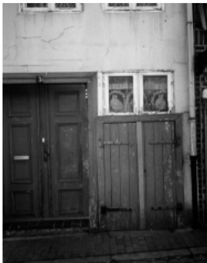
Portal- und Kellerabgang vor der Freilegung
