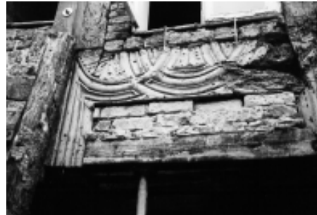
Vorhangbogen nach der Freilegung
