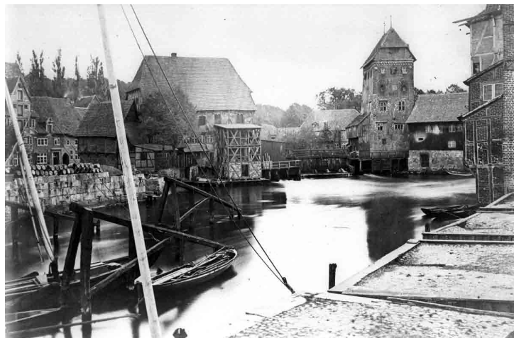
Das Idyll des alten Lüneburger Hafens an der Ilmenau mit dem Abtwasserturm im Hintergrund. 15 Foto: J. Makovec
