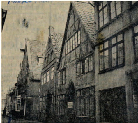
DAS WAR DIE ECKE vor dem Abriss: Mitglieder des ALA hoffen daß die Bezirksregierung auf den Widerspruch gegen die Neubauer laubnis eingeht und doch noch den Bau rekonstruierter mittelalterlicher Bürgerhäuser ermöglicht. 18.3.77
