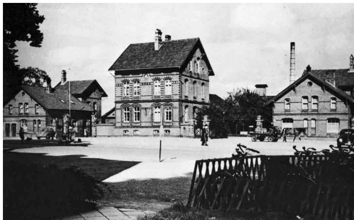
Schlachthof von 1892 mit Vorplatz. H
