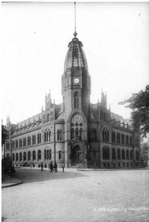
DAS POSTGEBÄUDE Auf dem Meere - im neugotischen Stil erbaut und mit dem markanten Isolatorenturm. 28 Foto: mac
