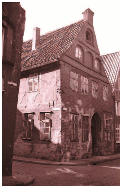
Auf dem Meere 35, vor dem Abriss Foto Rothgarn
