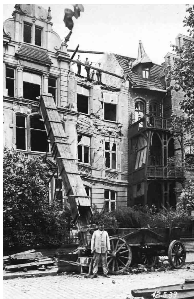
Frommestraße 2/3. Abriss 1933 nach Häusereinsturz infolge Senkungsschäden. N
