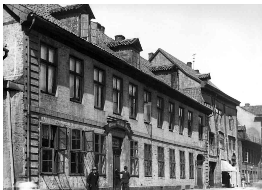
Neue Säule 9 und 8. Abbruch Nr. 8 1961, Nr. 9 1963 K
