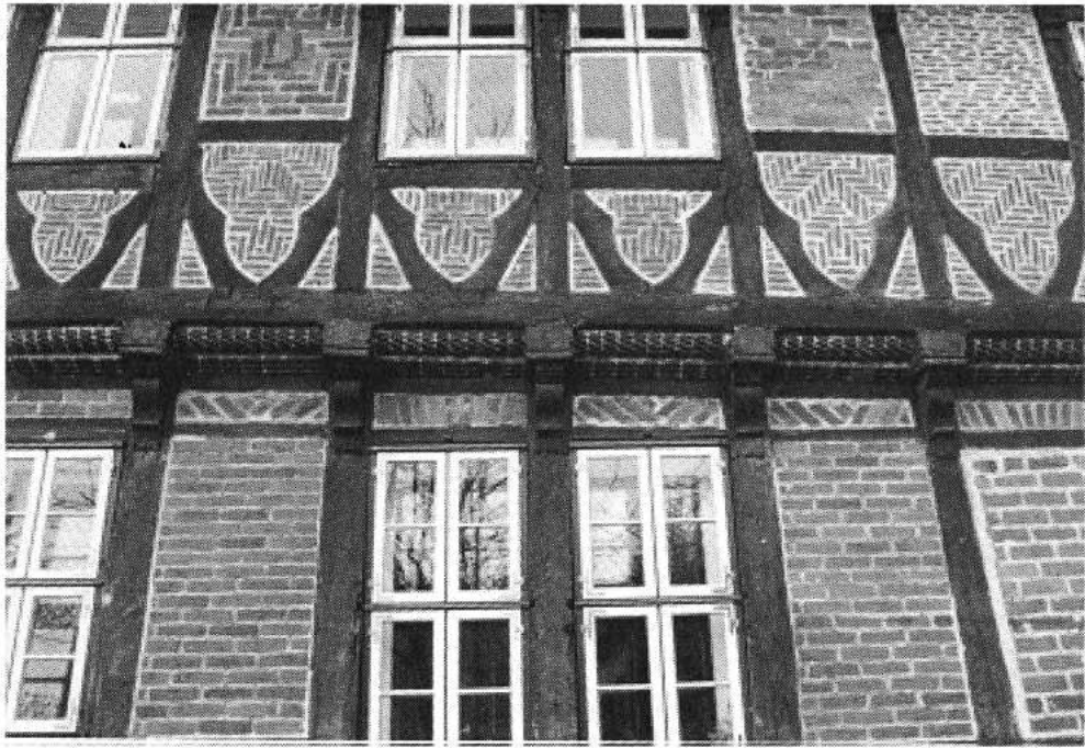
Abbildung 9 Zierausfachung an der Ostfassade
