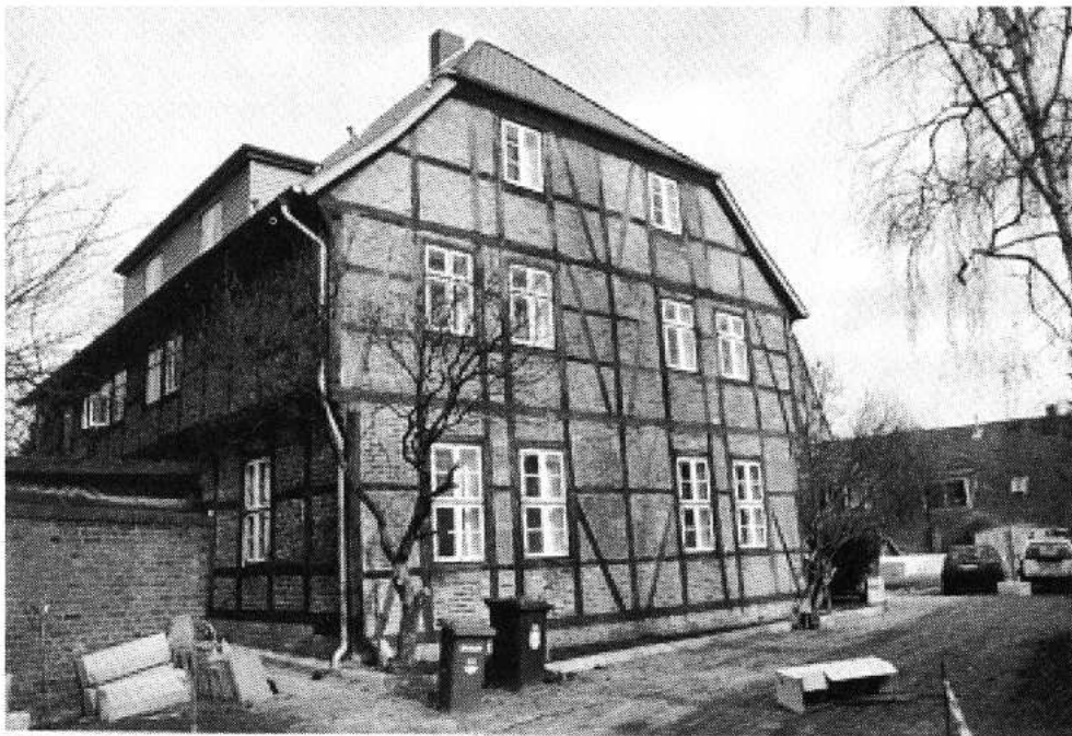
Abbildung 12 Ansicht der Südfassade
