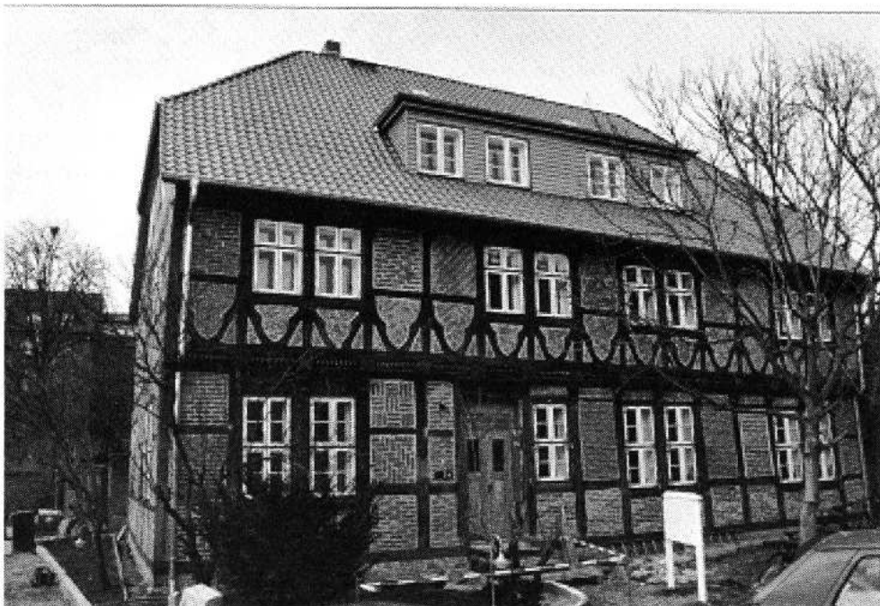
Abbildung 5 Ansicht der Ostfassade während der Sanierung
