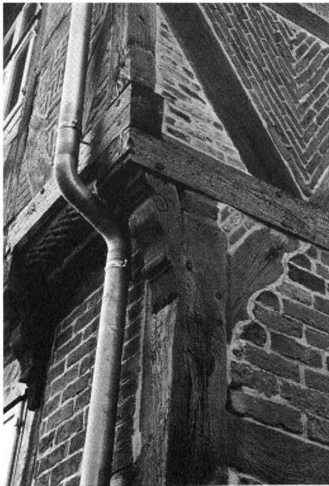
Abbildung 10 Knagge des 1. Obergeschosses
