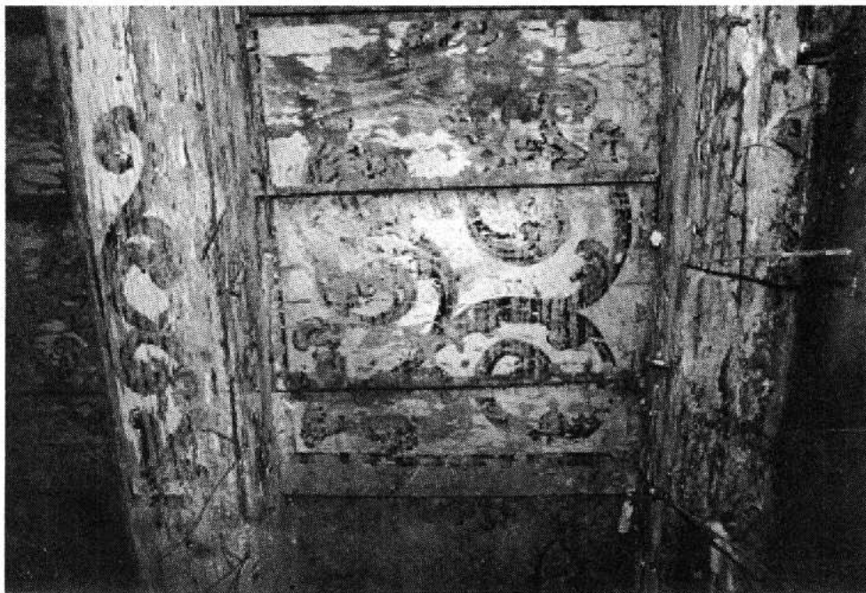
Abbildung 18 Bemalte Decke in der nördlichen Stube, erstes Obergeschoss
